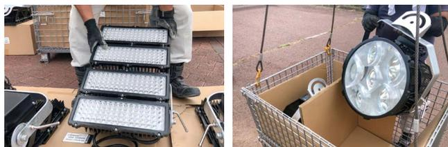
した。全部で330台ある照明をすべてLEDに置き換える工事ですが、照明の機器の大きさや重さを現状以下に抑え、そして、もちろんこれまでの3倍の照度である1,500ルクスを確保できなければ、基準を満たすことはできません。非常に細かな調整が求められる工事でした。
